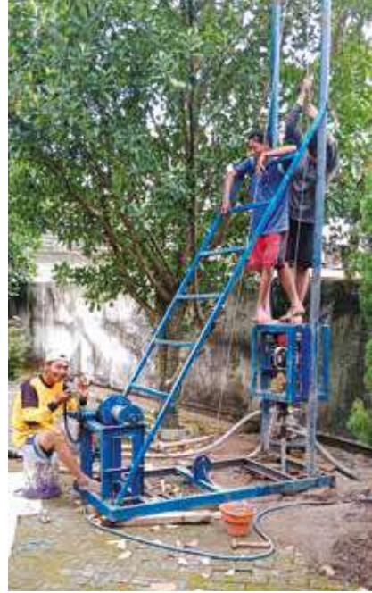
Οἱ ἐργασίες ἀντλήσης πόσιμου νεροῦ ξεκίνησαν.
